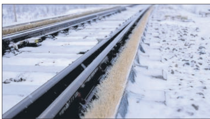
Bürstenleiste für Weichen: Osborn-Mitarbeiter (oben, von links) Ann-Kathrin Rein (Vertrieb), Projektleiter Lasse Becker und Marketingleiterin Kerstin Martens mit dem Bürstensystem Turb-Fly, das Eisenbahnunternehmen hilft, Weichen von Schnee und Eis freizuhalten. Rechts das an einer Weiche in Skandinavien montierte System. Foto: Biedenbach/nh
