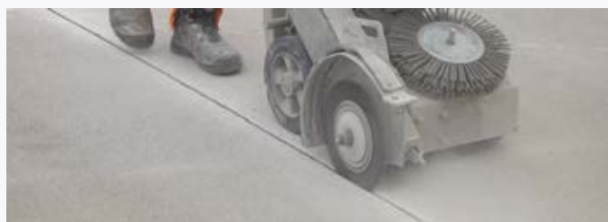
Perie curățare rosturi de îmbinare utilizată în construcția de drumuri
