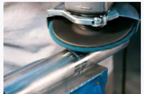
Slipning av fina svetsfogar och borttagning av termisk missfärgning
