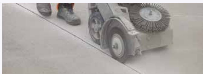
Brosse à joints utilisée dans la construction des routes
